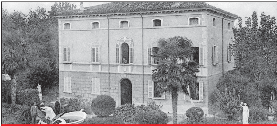
LA VILLA «DELLA MARCHESA» IN BASSO SI VEDE LA STATUA DETTA «L'OCARONE»
