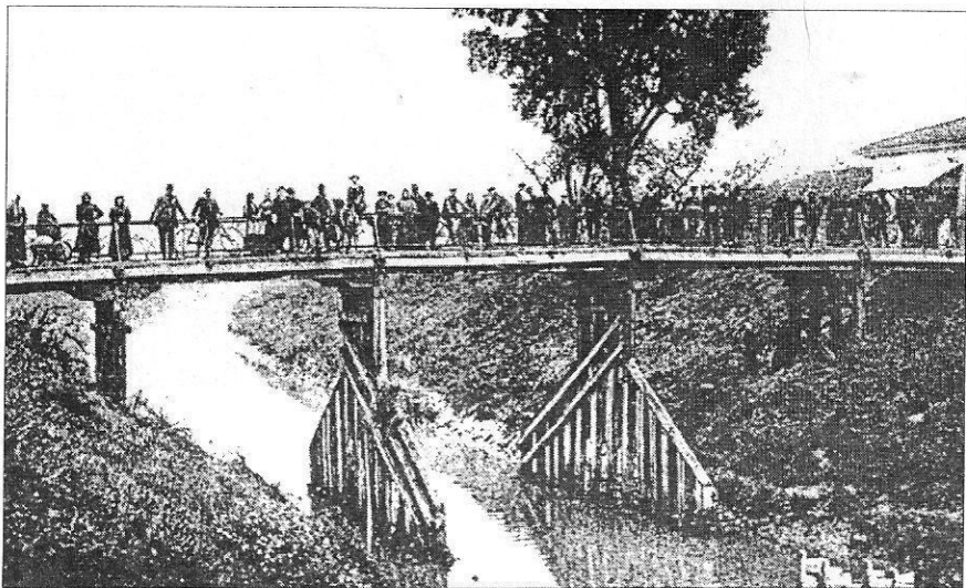
Ponte "vecchio" con le campate di sostegno in legno e le ochette nell'acqua chiara
