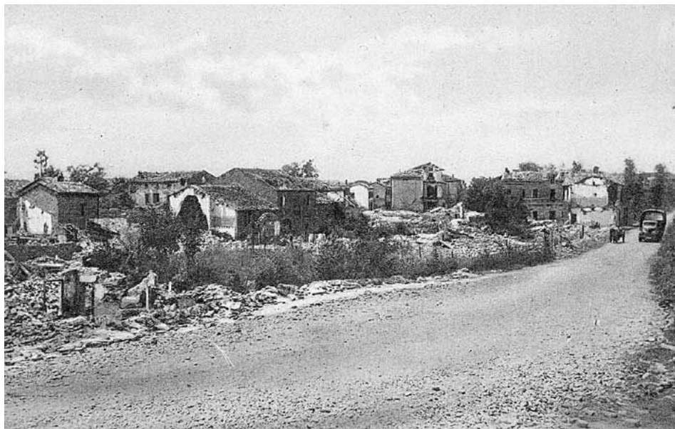
... Non si vide nessun tedesco lungo quella strada... (Rampa del fiume, Via Reale, zona "Sabbioni")
