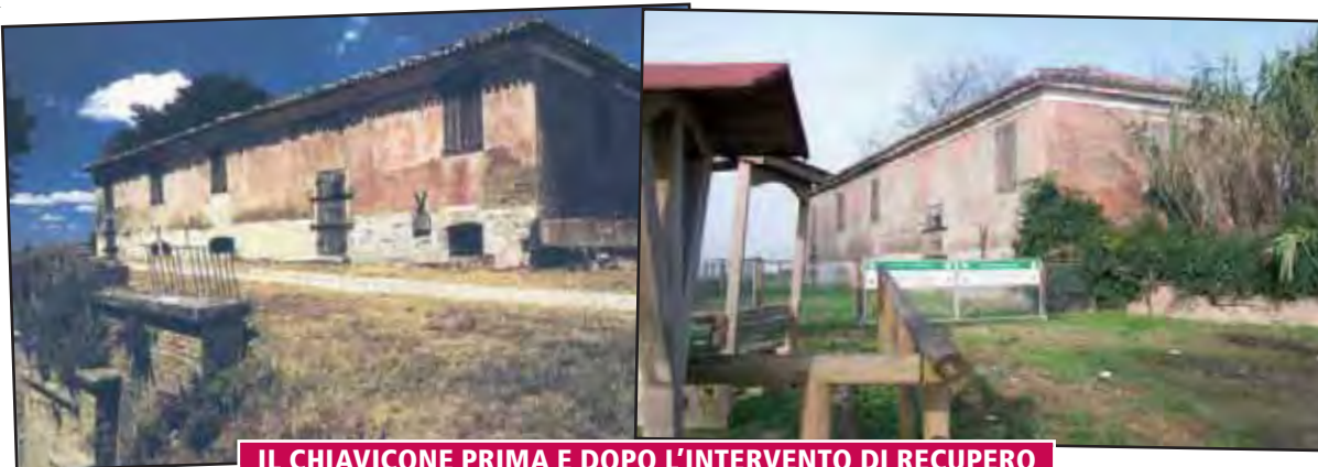
IL CHIAVICONE PRIMA E DOPO L'INTERVENTO DI RECUPERO
